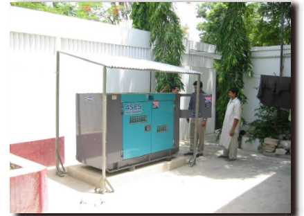
Là nguồn điện dự phòng khẩn cấp trong bệnh viện.
